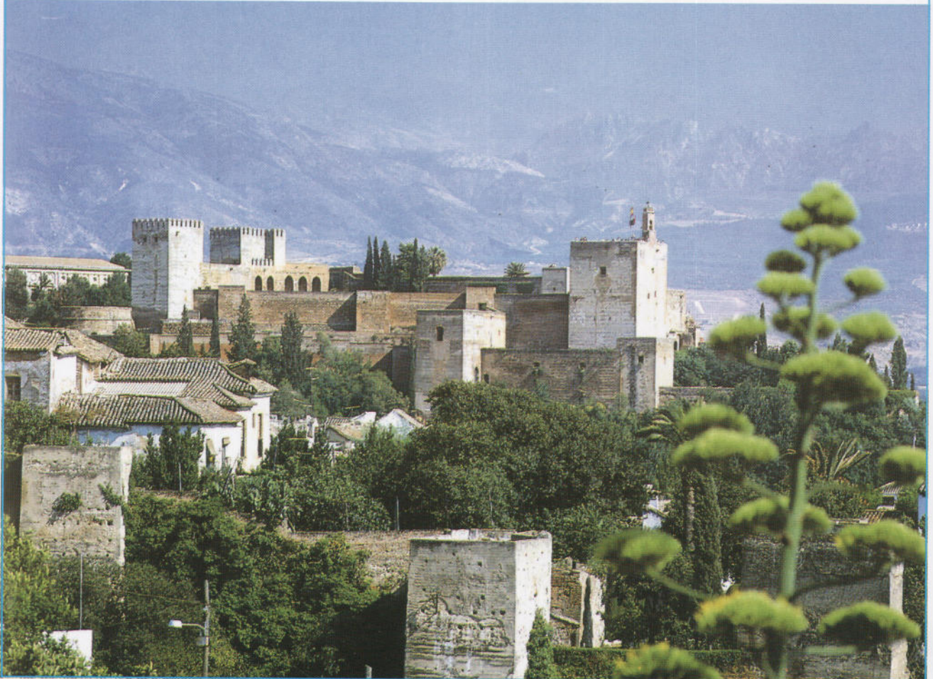
منظر لبقايا مدينة الحمراء
