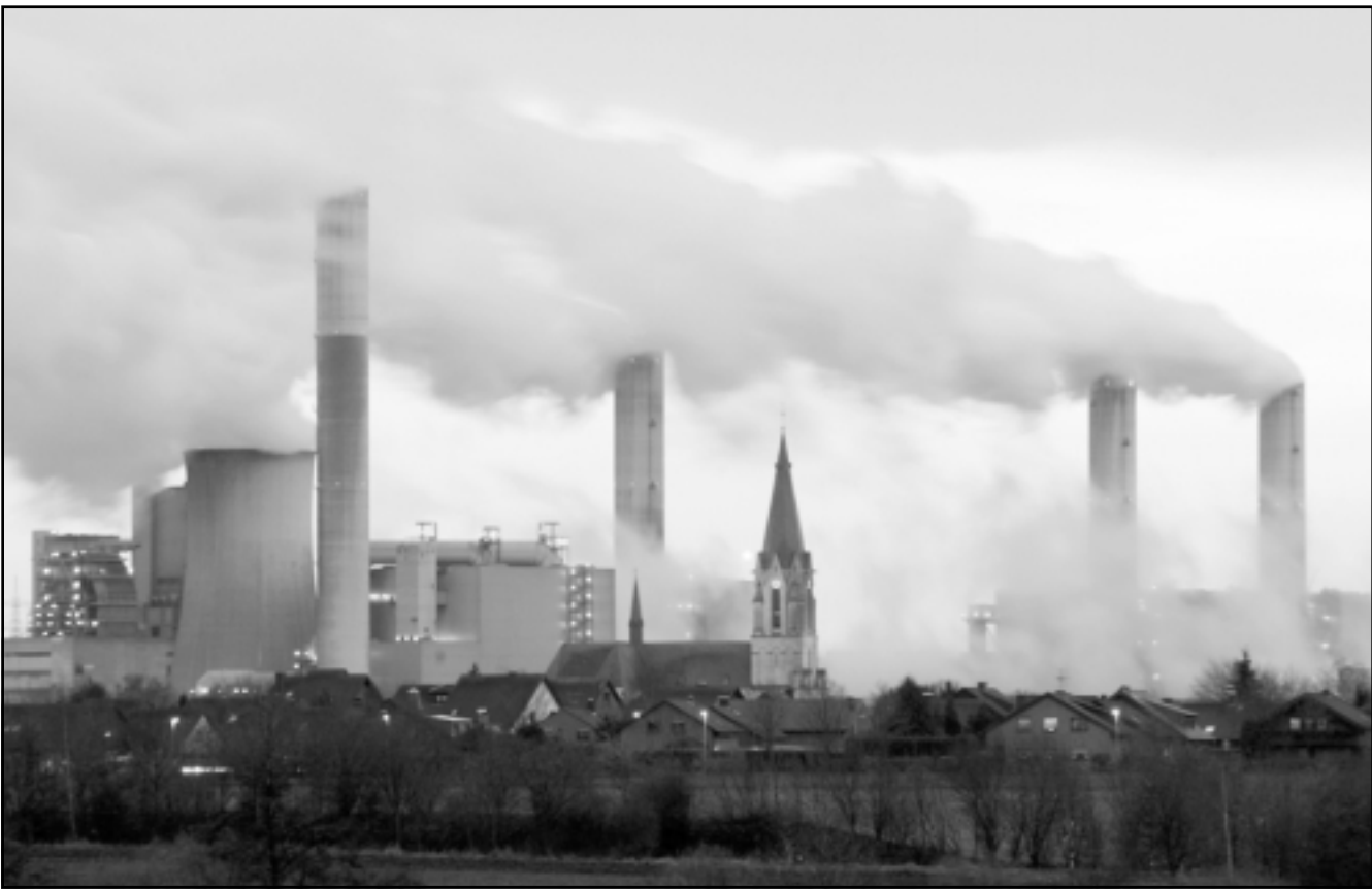
سحب الدخان تتصاعد من مداخل إحدى محطات توليد الطاقة التابعة لشركة (آر دبليو إي إيه جي) الألمانية في قرية غسدورف الى الغرب من كولونيا
