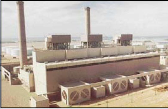
شكل (٨٢) محطة لتحلية المياه
