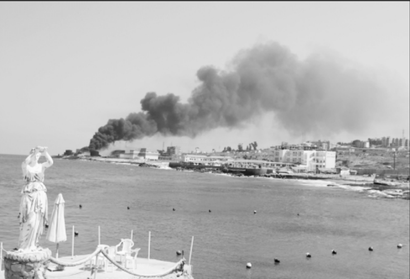
الدخان يتصاعد من محطة الجية لتوليد الكهرباء الواقعة جنوب بيروت والتي تعرضت لقصف الطائرات الاسرائيلية مما قلص قدرتها بدرجة كبيرة
