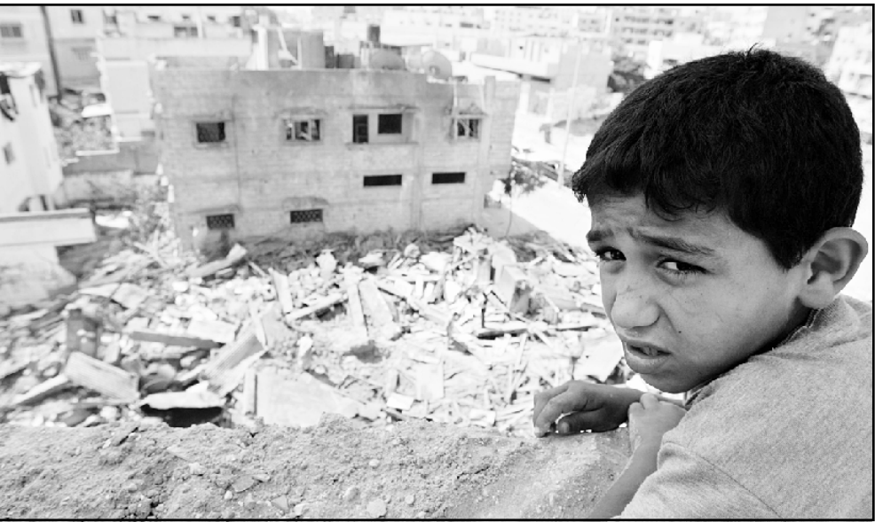
فتى فلسطيني أمام المبنى الذي دمرته طائرات الاحتلال الاسرائيلي في غزة
