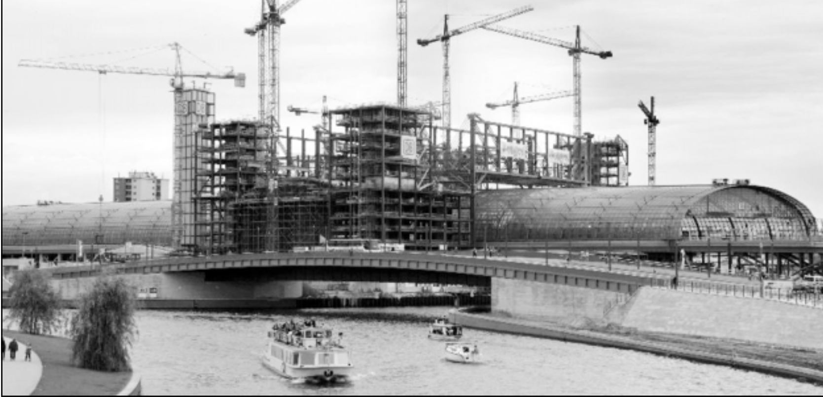
صورة بانورامية للمحطة خلال عملية البناء
