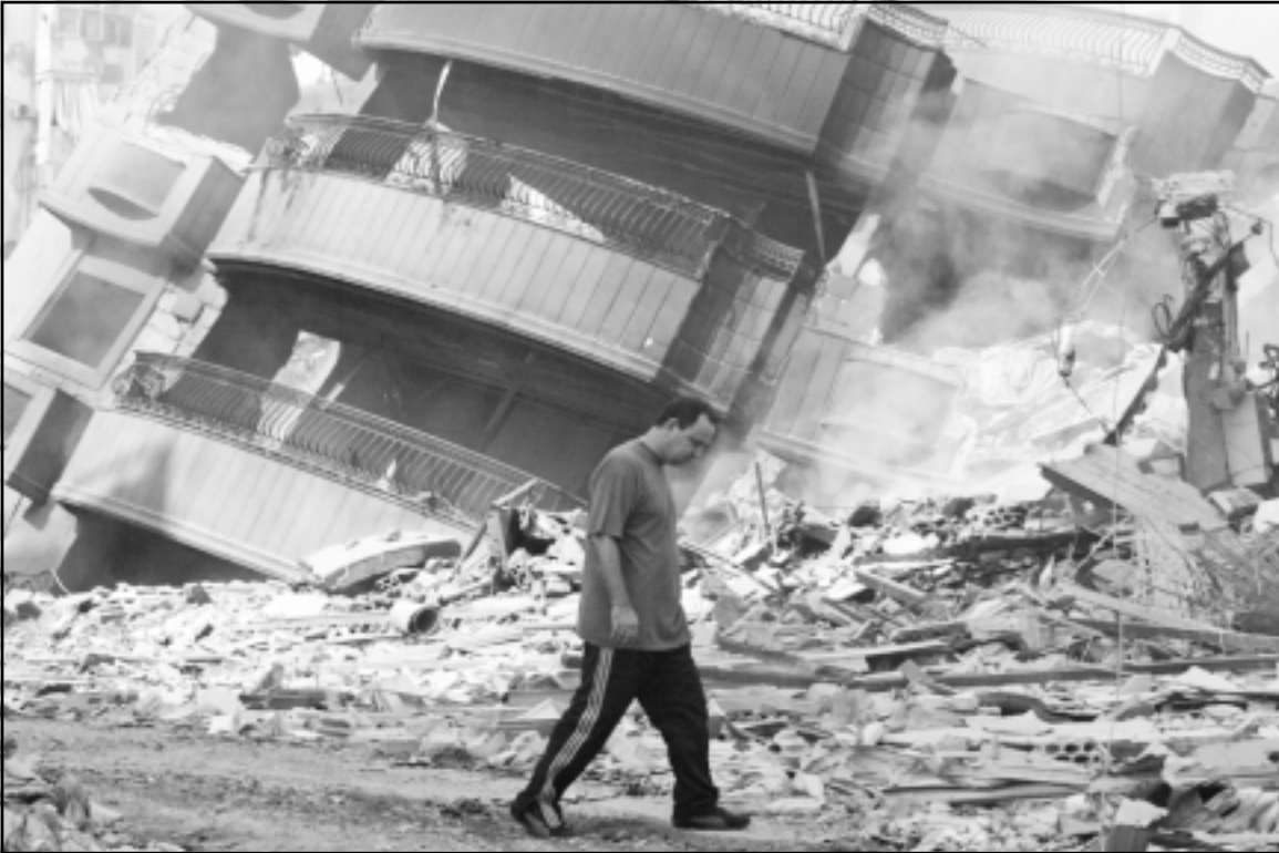
لبناني يسير امام بناية مدممة بقصف اسرائيلي في الضاحية الجنوبية ببيروت
