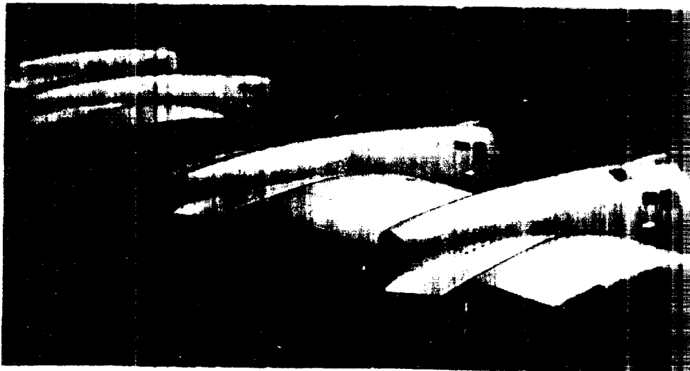
Фиг. 40. Центроплан с гондолами (без закрылков).
