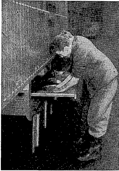
Bild 3. So sind die Waschbecken eingebaut
