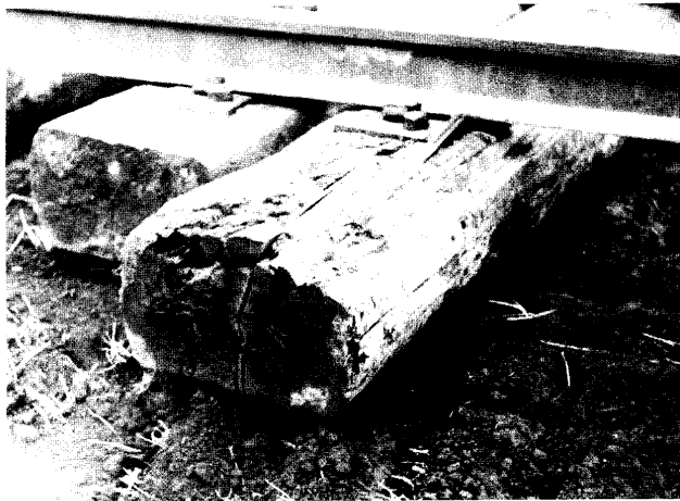
Traverse détruite. Du côté frontal se voient clairement les champignons qui détruisent le bois.
