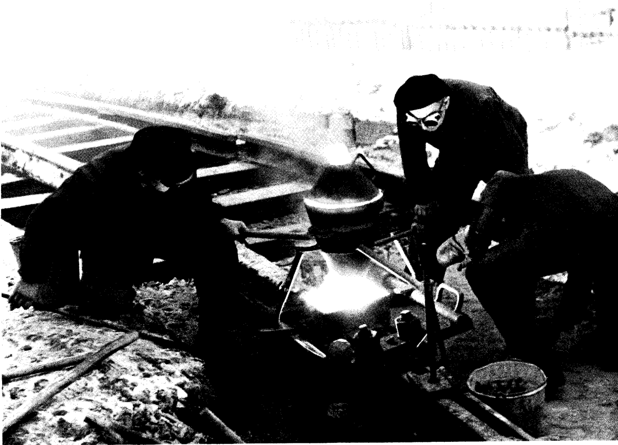
Percement d'un soudage AT.
