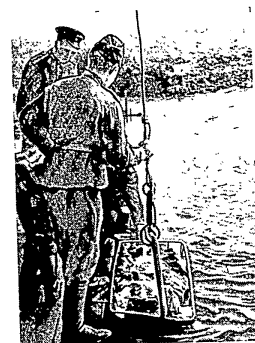
Рис. 6. Установка контейнера с балластом на внешней стороне блоков моста.
