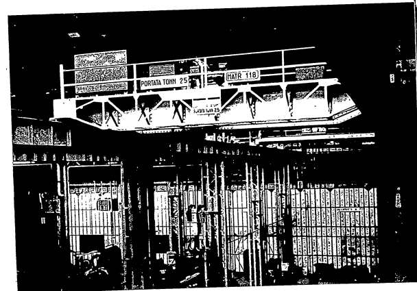
Gru elettrica a ponte da 25 tonn. scartamento m. 18,67 - Riva (Milano)
