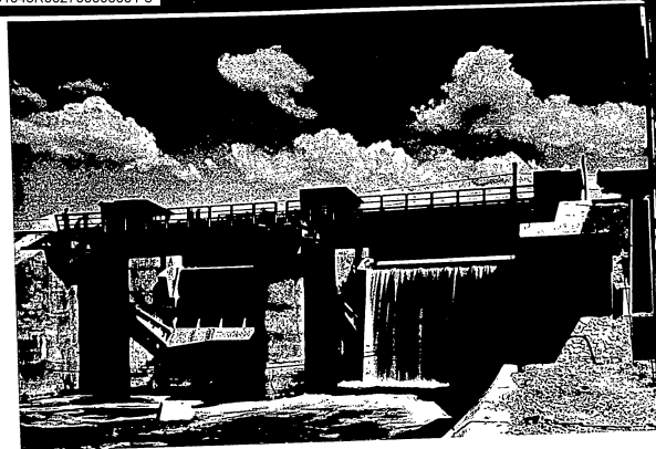
Impianto del Basso Nero - Centrale di Orte n. 2 paratoie automatiche a settore con ventola automatica luce = m. 14 x 7,25 + 1,8 panconature e carroportico per panconi
