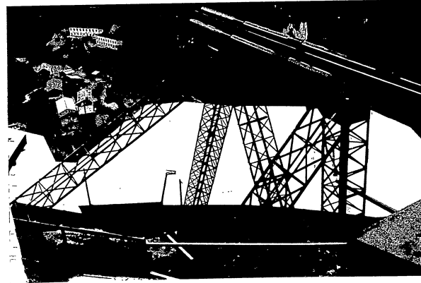
Piano di scorrimento in curva del biondin Diga di Val Gallina (Belluno)
