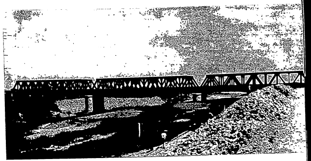
Ponte ferroviario sul Reno tra Bologna e Ferrara (in collaborazione) n. 1 campate di m. 51,36
