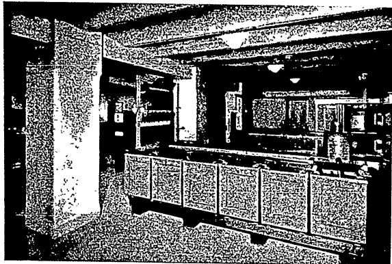
Batteria di accumulatori Tudor presso la stazione telefonica amplificatrice di Viterbo.
