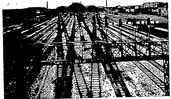
Veduta panoramica della stazione viaggiatori F. S. di Milano Centrale (comandi elettrici funzionanti con accumulatori Tudor ).
