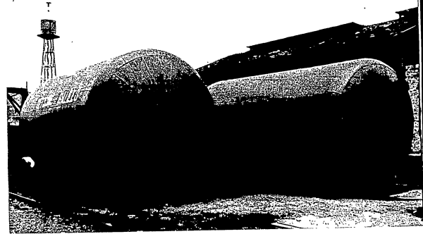
Serbatoi a pressione per la centrale termoelettrica di Marghera (Venezia) diametro m. 4 - lunghezza m. 8
