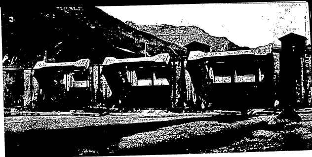
Sbarramento sul Piave a Soverzene (Belluno) n. 3 paratoie automatiche a settore luce = m. 12 x 3,9
