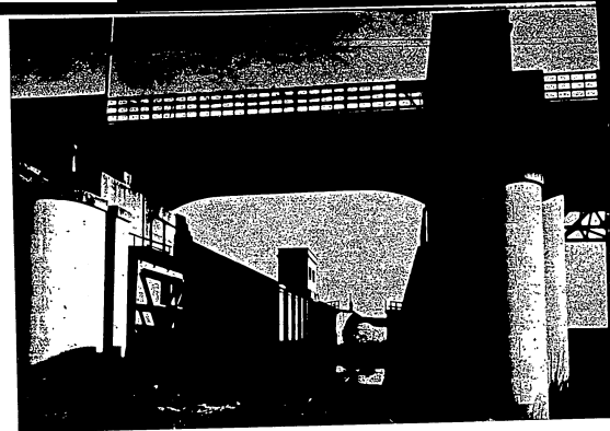
Conce di navigazione a Buoro sul Gorzone (Rovigo) per natanti da 300 tonn. porte a vento luce = m. 7,5 x 4
