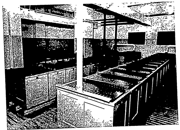
Batteria di accumulatori Tudor in funzione presso la R. A. I. di Milano.
