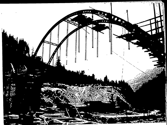
Armature metalliche da incorporare nel calcestruzzo per il ponte canale sul Sarca di Campiglio derivazione Sarca Molveno per l'impianto di S. Massenza 1 a (foto Pedrotti)
