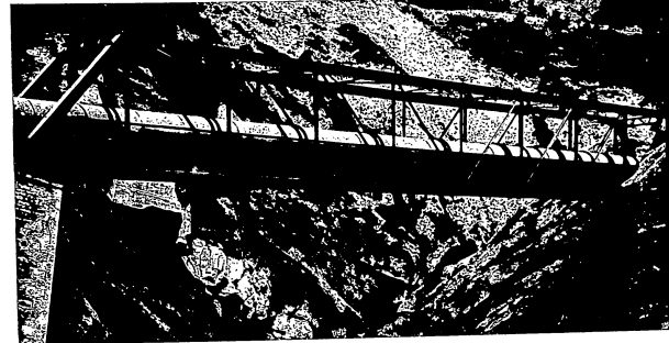
Passerella metallica sostegno conduttura acquedotto Alto Savio - Quarto di Sarsina (Rimini)
