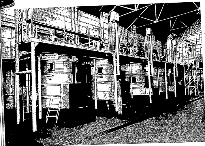
Impianto di forni a nafta per riscaldamento autoclave e fusione colofonia Furnaces plant, oil fired type, for heating autoclaves and melting colophony Sección de hornos a nafta para calefacción autoclaves y para fundición de pez colofonia
