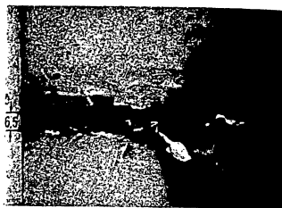
4. Горизонтальный шов между панелями имеет 6,5 см, в то время как вертикальный — 1,5 см.
