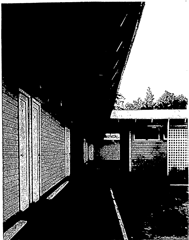
7 Крытый проход к санитарному блоку
