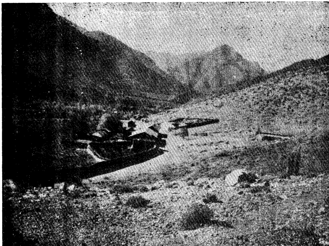
(Fig. 2).—Vista panorámica del caserío de Macano.
