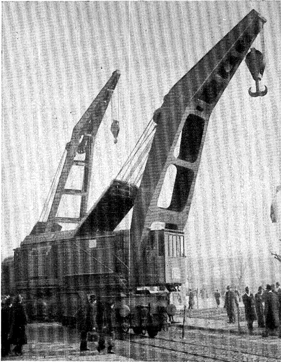
Der 50-t-Eisenbahnkran der Fa. Unruh & Liebig findet seine Verwendung beim Laden und Entladen schwerer Lasten, beim Bau und Montage, beim Schienenlegen, bei Unglücksfällen und ähnlichen Aufgaben.
